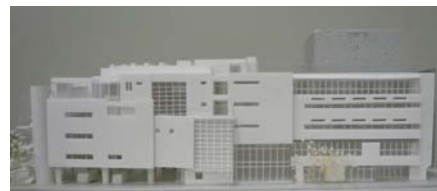
建物の全景（線路側から見た図）
